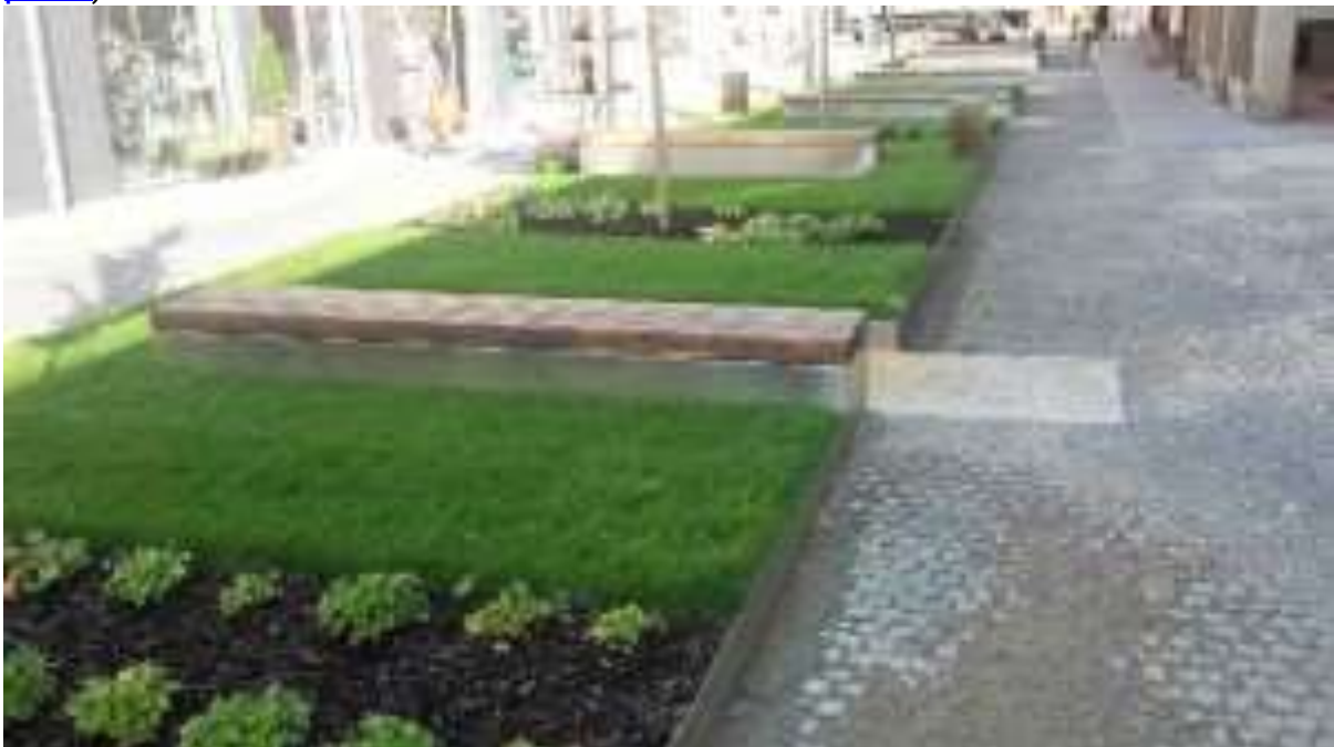
Foto 6: Veselí nad Moravou našlo súvislosti s adaptáciou na klimatické zmeny efektívne riešenie: riešenie zelenej plochy v pešej zóne – pri využití vlastností dosiek STERED možno dosiahnuť : lavička ako zásobník vody – STERED ID doska pod trávnikom zabezpečuje dlhodobú evaporáciu vody zo zásobníka – účinné opatrenie na zvlhčovanie ovzdušia (zdroj: http://www.stered.sk/novinka/vyuzitie-vlastnosti-dosky-stered-id-ako-retencnej-zlozky-v-skladbe-environmentalnych-spevnenych-ploch )
